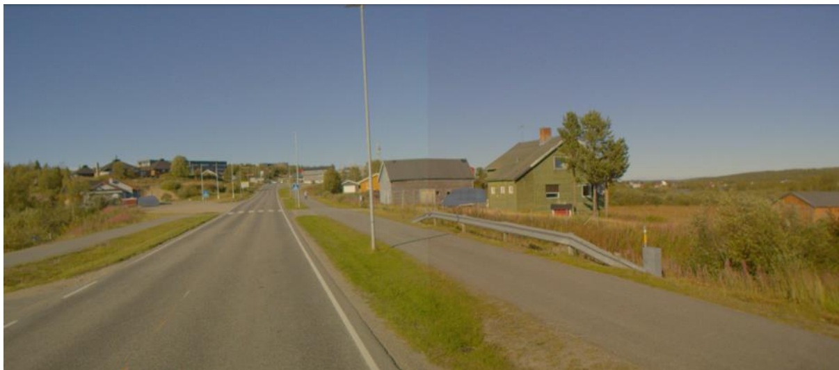
Figur 41 // Bildet er hentet fra vegkart.no og viser europavei E45 i 2022, på den strekningen som må krysses av skolebarn på vei til Kautokeino skole. Det er fortau, fotgjengerfelt og god sikt, og fartsgrensen på denne delen gjennom sentrum er 50 km/t.
