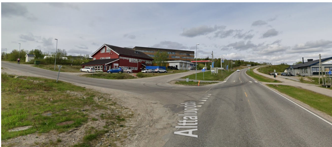
Figur 4 Gangfelt over E45 og kryss med fv. 7978 Hånnoluohkká, foto Google Maps.
