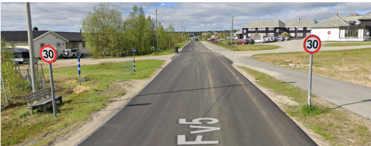
Figur 10 Fv. 7980 langs Kautokeino skole har en veistandard som innbyr til høyere fartsnivå enn skiltet fartsgrense, foto Google Maps.
