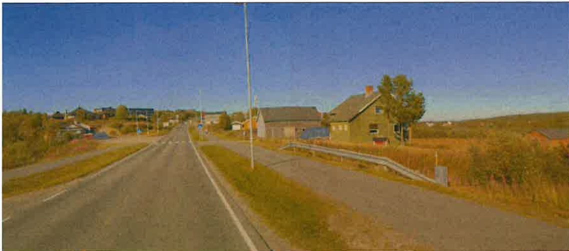
Figur 41 // Bildet er hentet fra vognkart.no og viser europavei F45 i 2022, på den strekningen som må krysses av skolebarn på vei til Kautokeino skole. Det er fortau, fotgjengerfelt og god sikt, og fartsgrensen på denne delen gjennom sentrum er 50 km/t.
