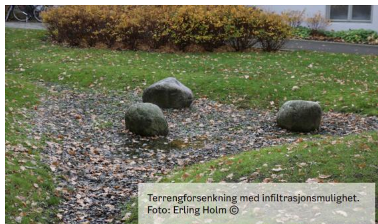
Figur 3-17 Eksempel på en nedsenket gressflate som samler og infiltrerer vann.
