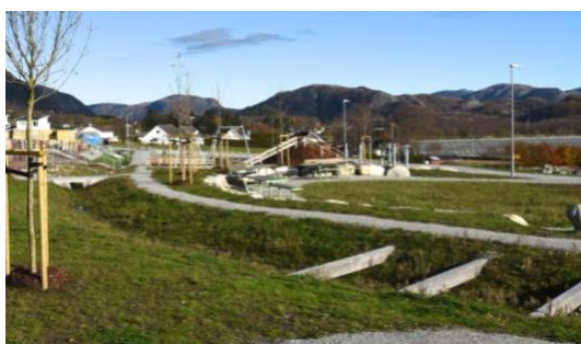
Figur 3-19. Eksempel på vadi (Vannfakta, 2021) (t.v) og prinsippkisse for oppbygging av vadi (t.h.).
