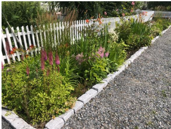
Figur 3-16. T.v.: Eksempel på regnbed. T.h.: Oppbygging av regnbed med drengslør.
