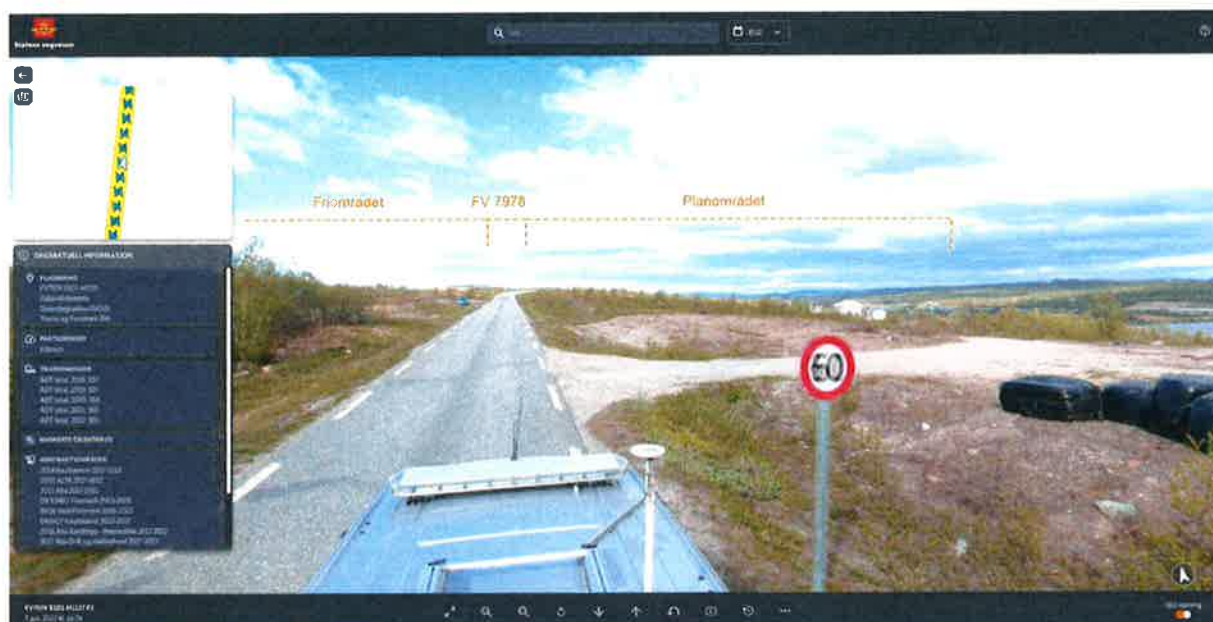
Figur 20 // Foto hentet fra vegkart.no sitt vegbilde-arkiv. Bildet er tatt i juni 2022 og viser fylkesveien i retning nord og planområdet med dagens traktorvei sett fra sørsiden av området
