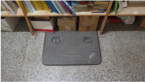
Foto 1. Luke i gulvet mot tankrom for fyringsanlegget ved skolen.
